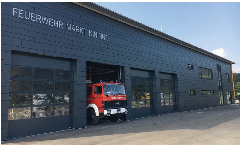
Feuerwehr Markt Kinding – Gerätehaus
