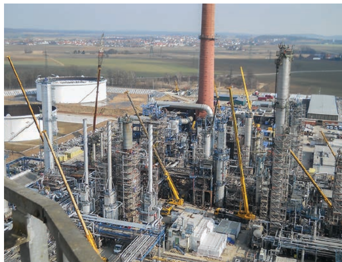
Einsatz von Arbeitskränen in einer Produktionsanlage.
