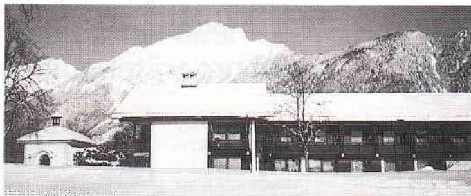
Haus Staufen mit Hochstaufer im Hintergrund
